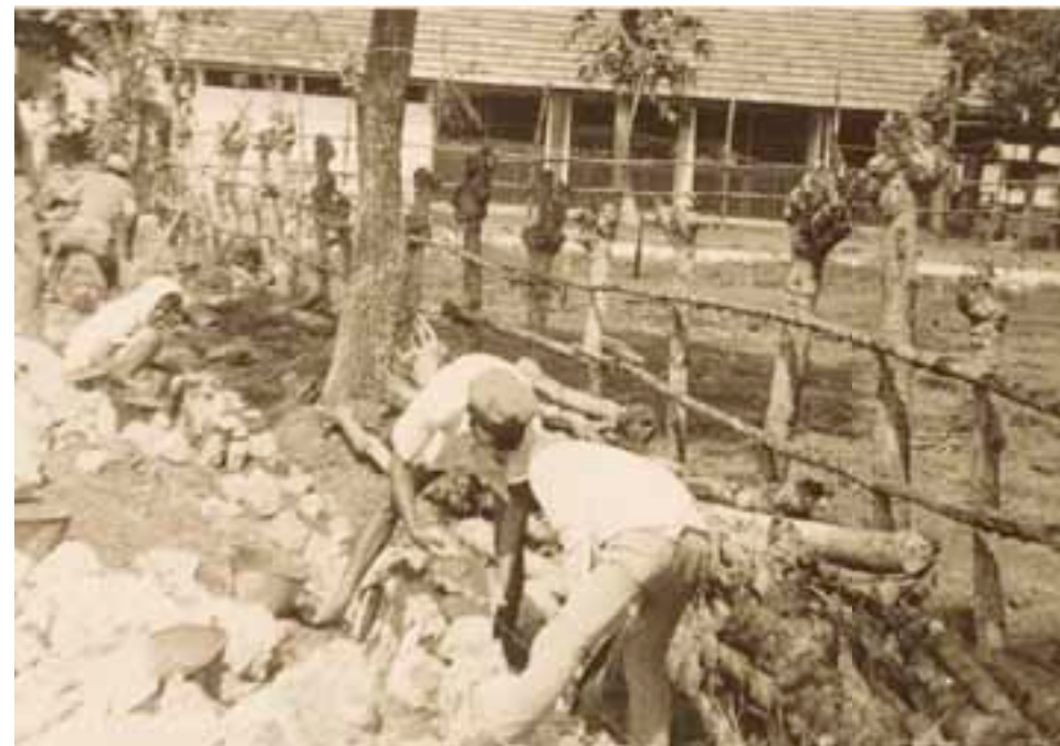
Graven van goten voor de fundamenteën en afsluiting met geplastificeerd harmonicaas
