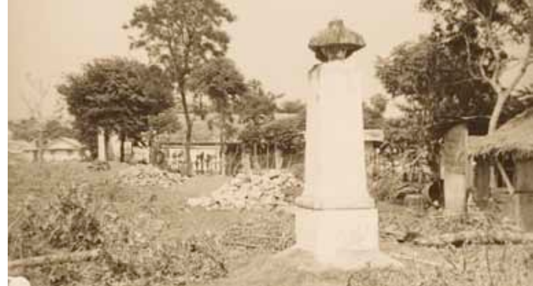
Het monument van Darlang 'heer der bergen' in gesloopte staat
