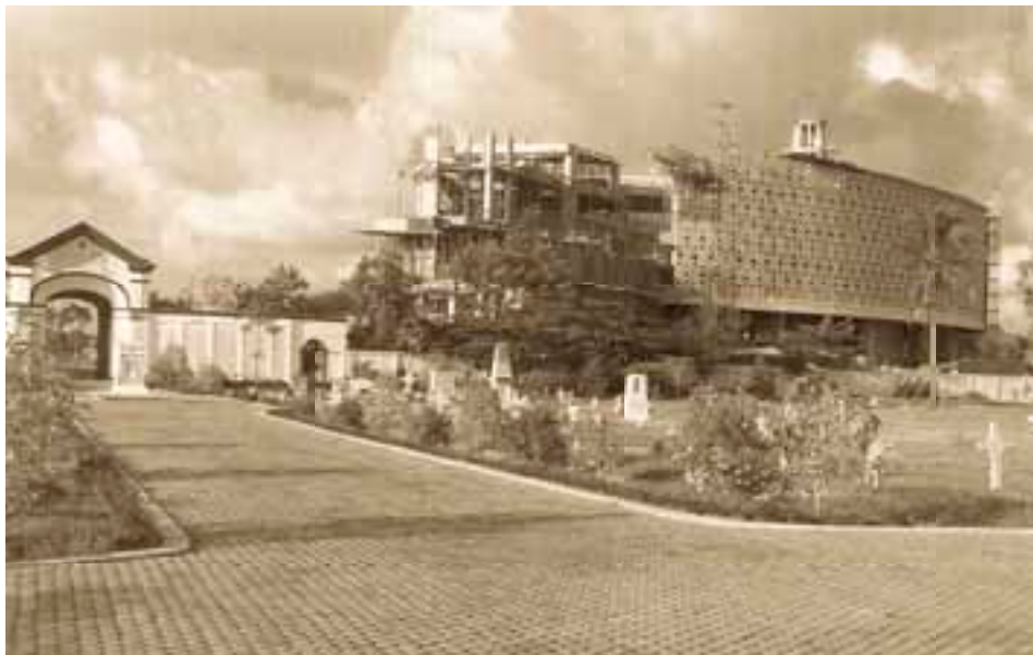
Links: Tsunami museum in aanbouw Rechts: Reconstructie van de muur en aanpassen van de toegangsweg
